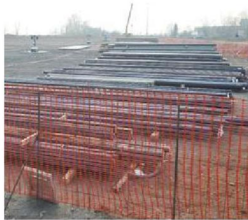
MAXI DEPOSITO Nelle foto il sito di stoccaggio dei materiali da impiegare nei due cluster di Cornegliano
